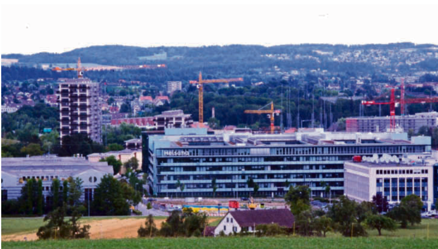
Eventpark: In die Lücke zwischen den bestehenden Gebäuden kommt das Gebäude, welches verschiedene Säle beherbergen wird. Martin Liebrich
